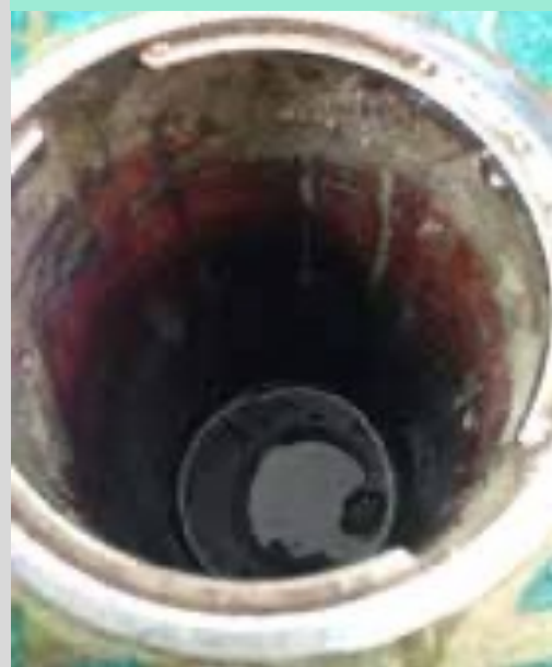
Resultados antes de la instalación
